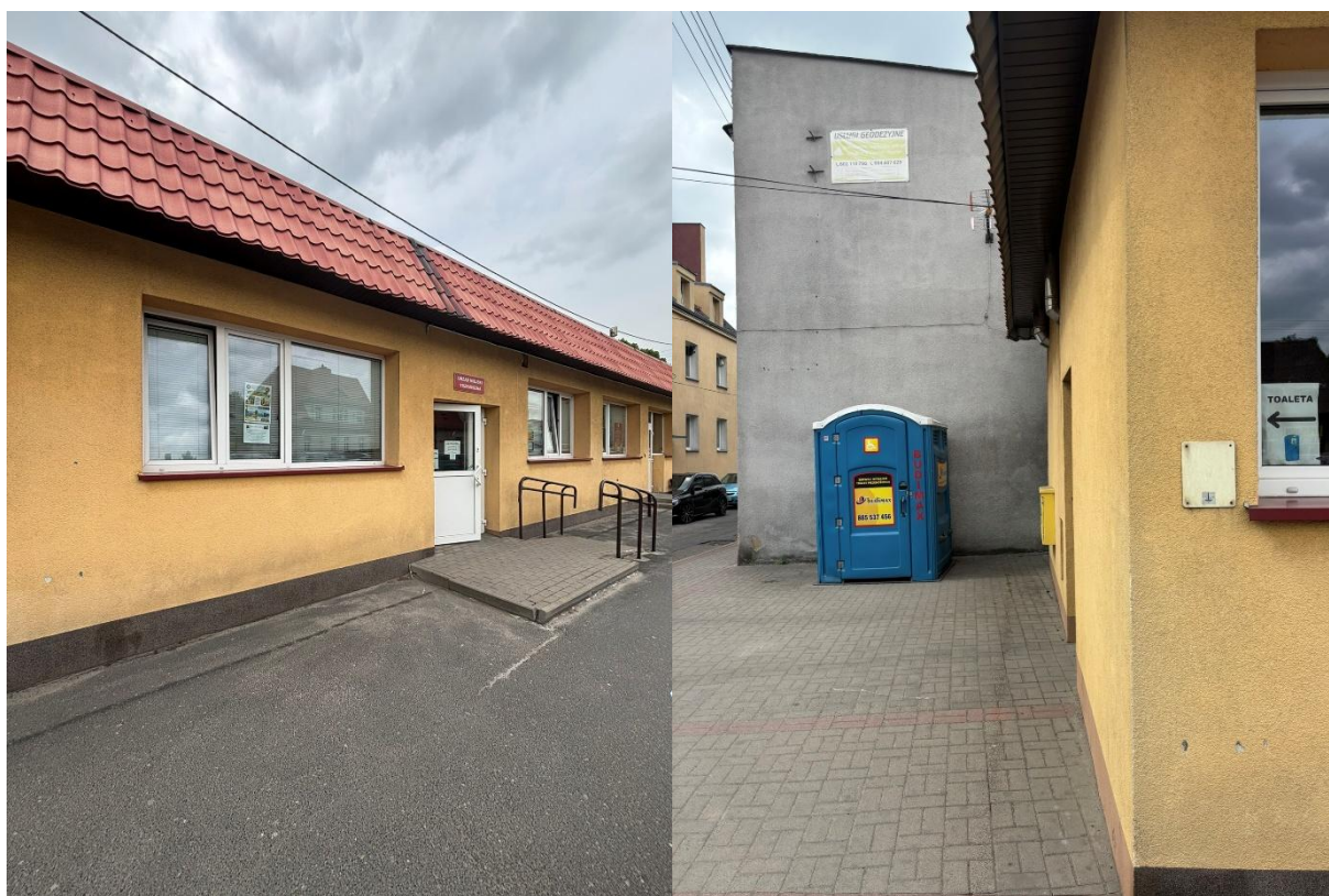
Ryc. 21 Nieużytkowany budynek przy ul. św. Wojciecha 19A
