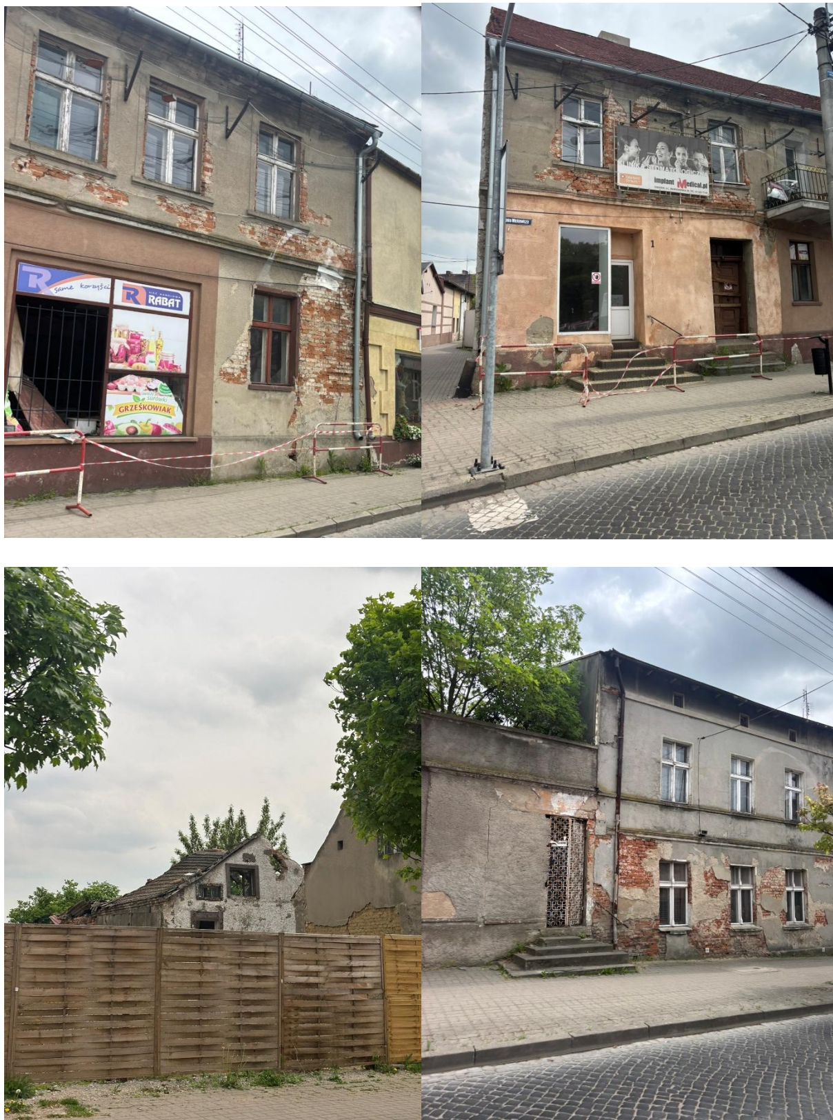
Ryc. 23 Przestrzeń i zabudowa w złym stanie technicznym
