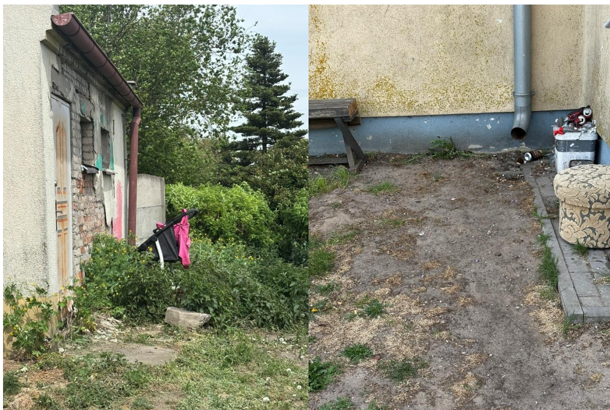
Ryc. 19 Budynek dawnej szkoły podstawowej w Jastrzębowie
