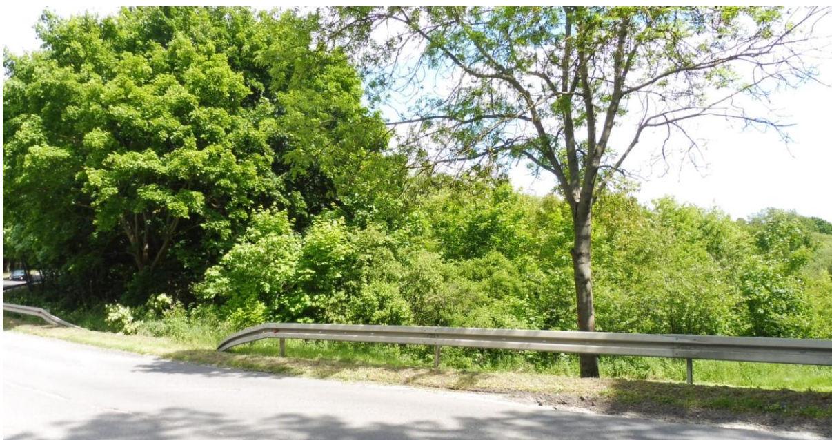
widok na działkę objętą wnioskiem – dz. nr 217/5 ( po prawej ) ; obniżenie barierek – wjazd dz. nr 241
